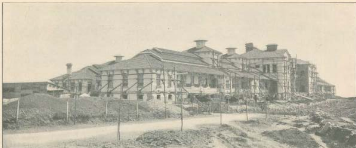
O NOVO SANATORIO DA PAREDE
