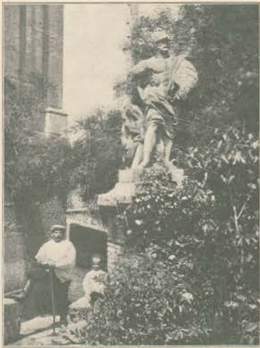
ENTRADA DO DEPOSITO EM CAMPOLIDE
