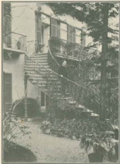
A ESCADA DO JARDIM
