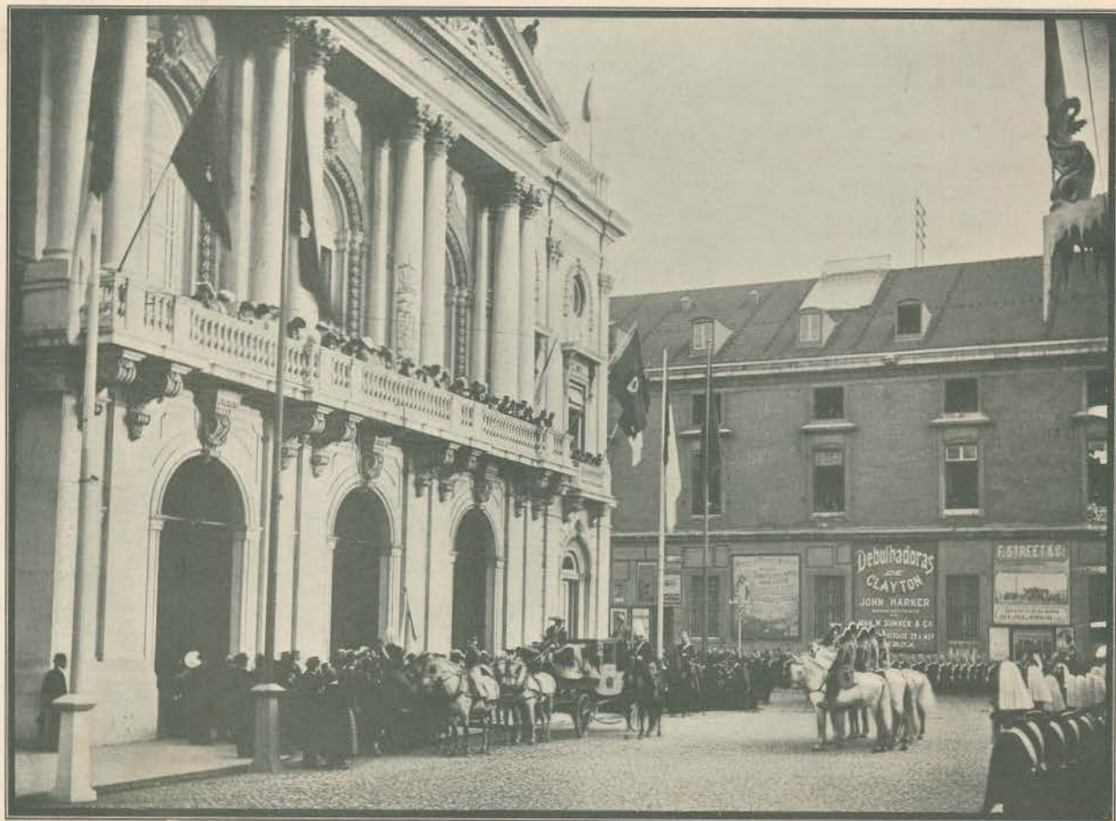
A VISITA DE S. M. CATHOLICA — A MUNICIPALIDADE RECEBENDO OS MONARCHAS À ENTRADA DO EDIFÍCIO
