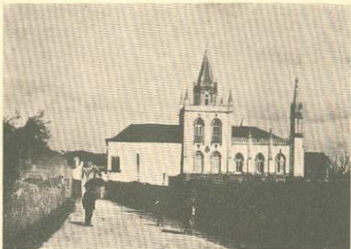
A CASA DE TAVAREDE ANTES DE SER REFORMADA
