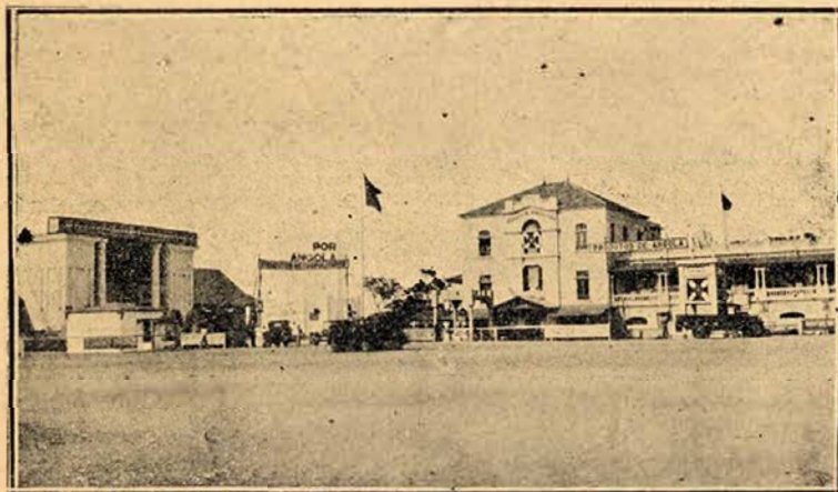
LUANDA — EDIFÍCIO ONDE SE REALIZOU A FEIRA DE AMOSTRAS DE PRODUTOS ANGOLANOS
