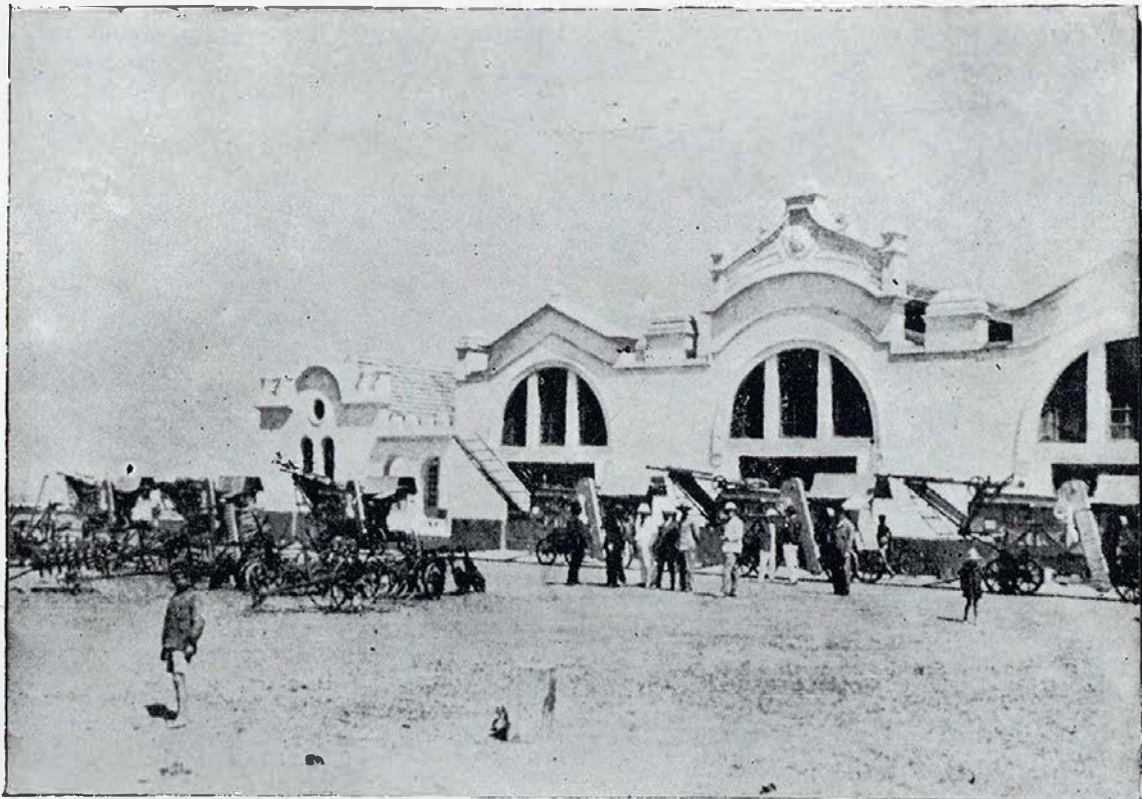
NOVA LISBOA — ESTAÇÃO DO CORPO DE BOMBEIROS
