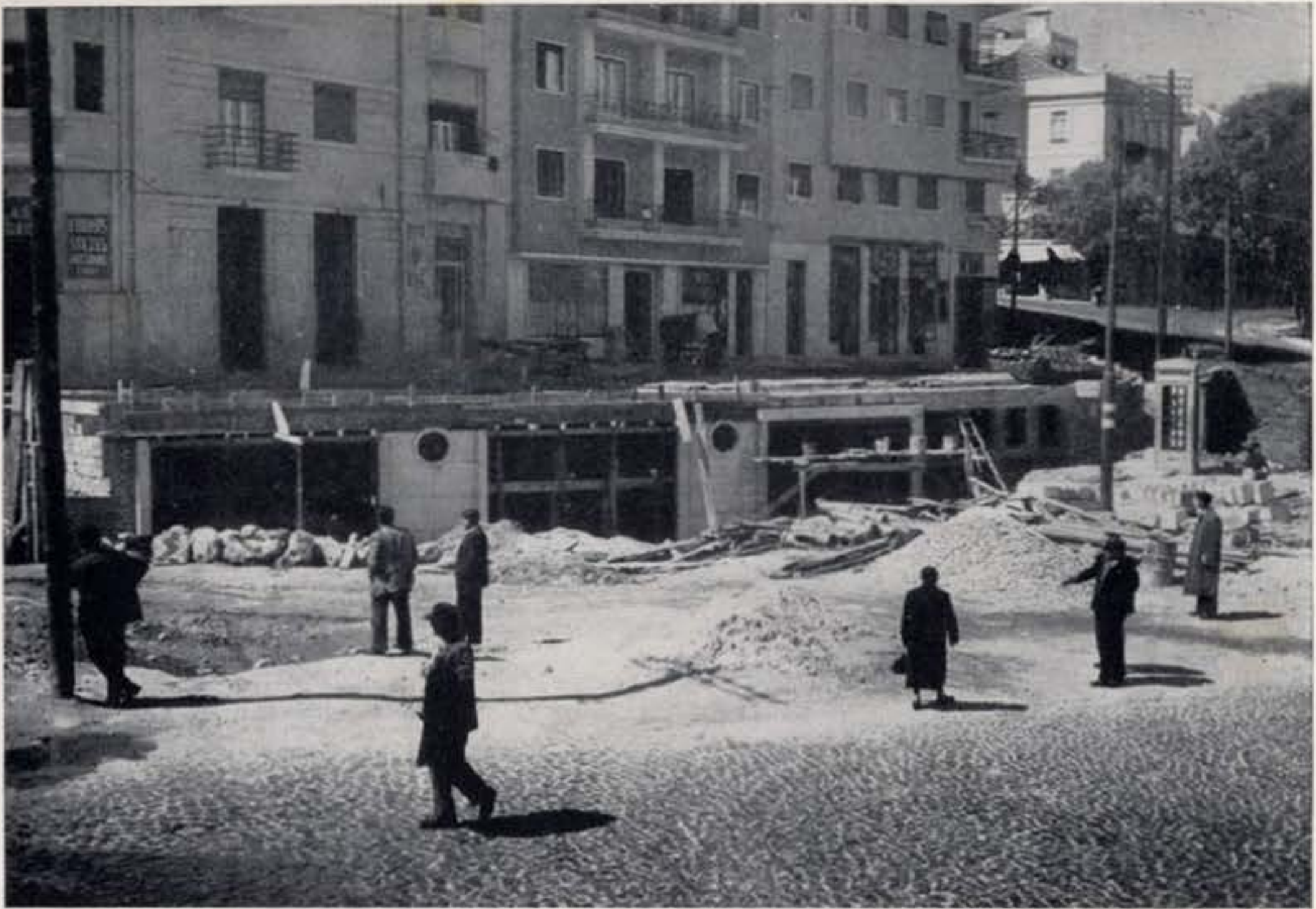
Lojas em construção no Largo de Santa Bárbara
