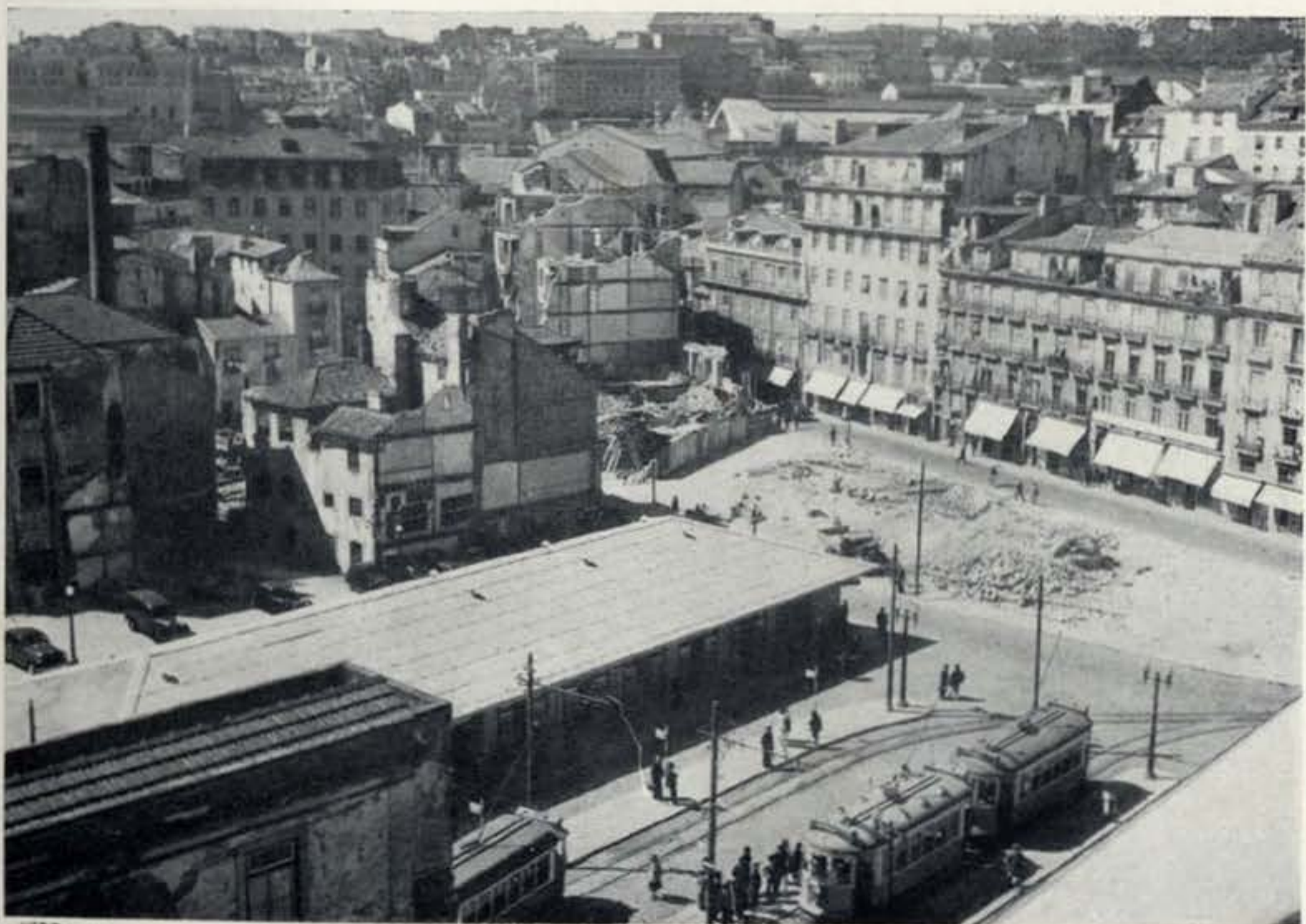
Obras no Largo Martim Moniz
