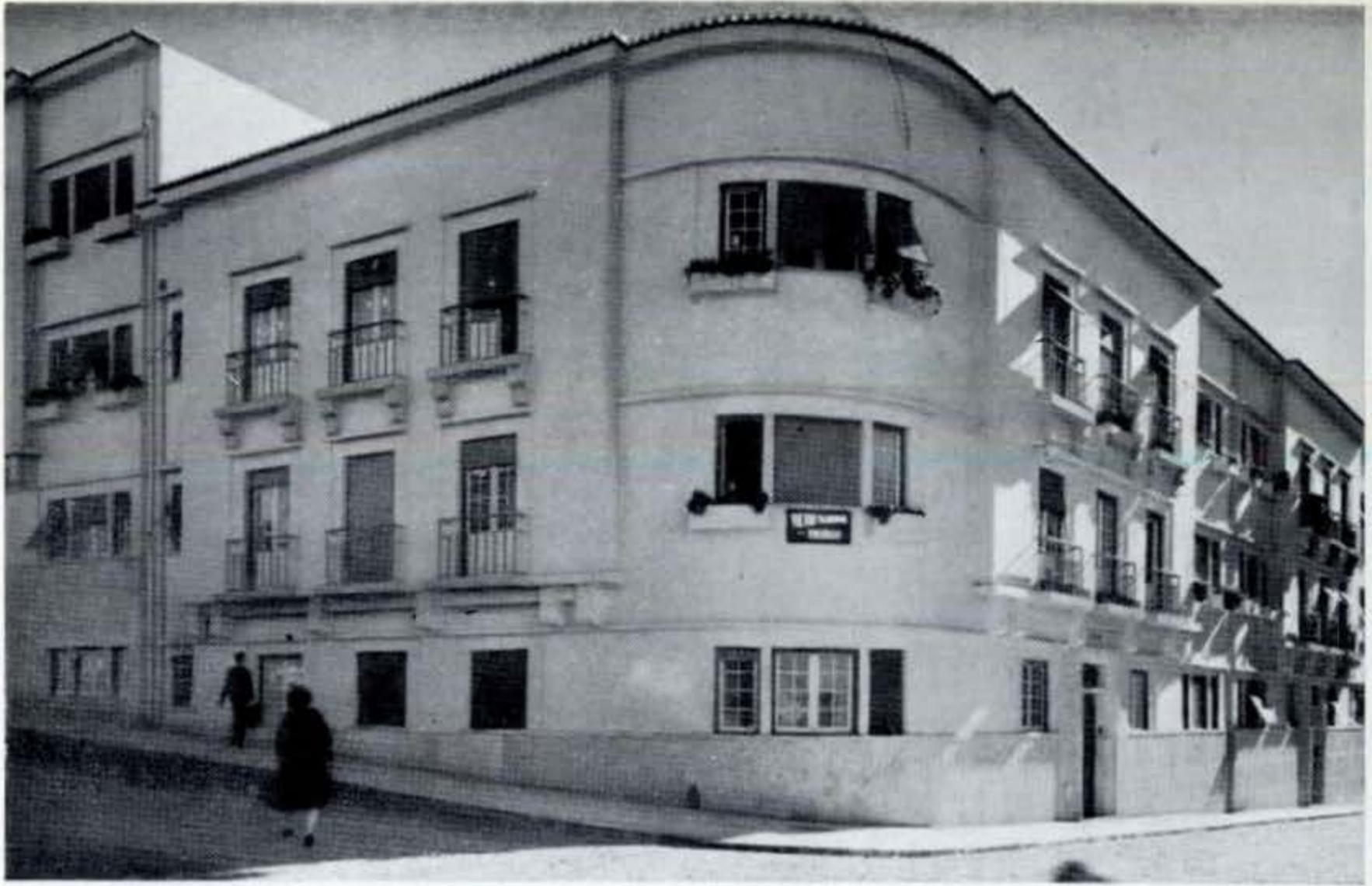
Bloco de construções da Rua Acúrcio das Neves, uma das primeiras iniciativas da Câmara Municipal destinada a orientar os proprietários e os construtores
